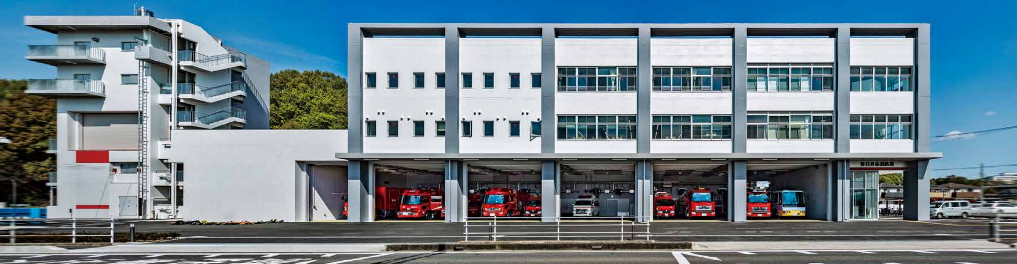
南側外観 旧国道19号(県道内津勝川線)より施設を望む
