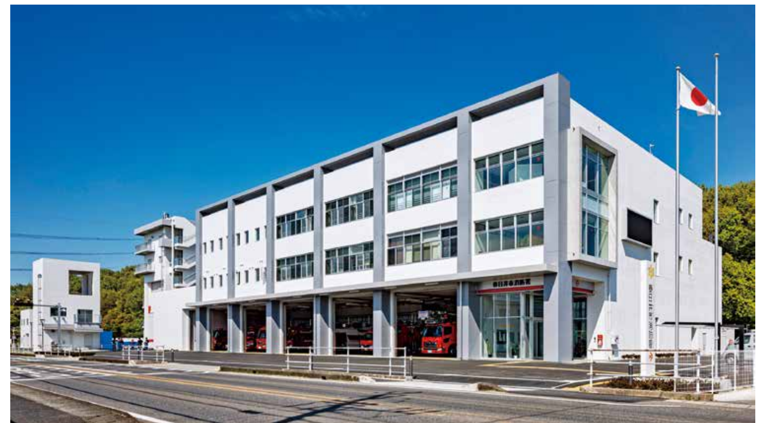
消防庁舎 南東側外観
